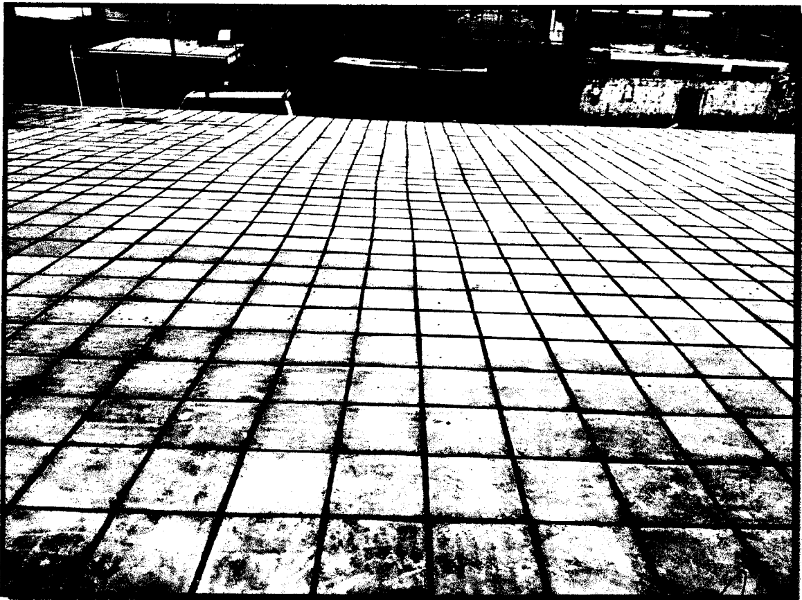
Vista 02. Ladrillo pastelero instalado.
